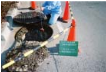
硫化水素ガス濃度調査状況(例)
